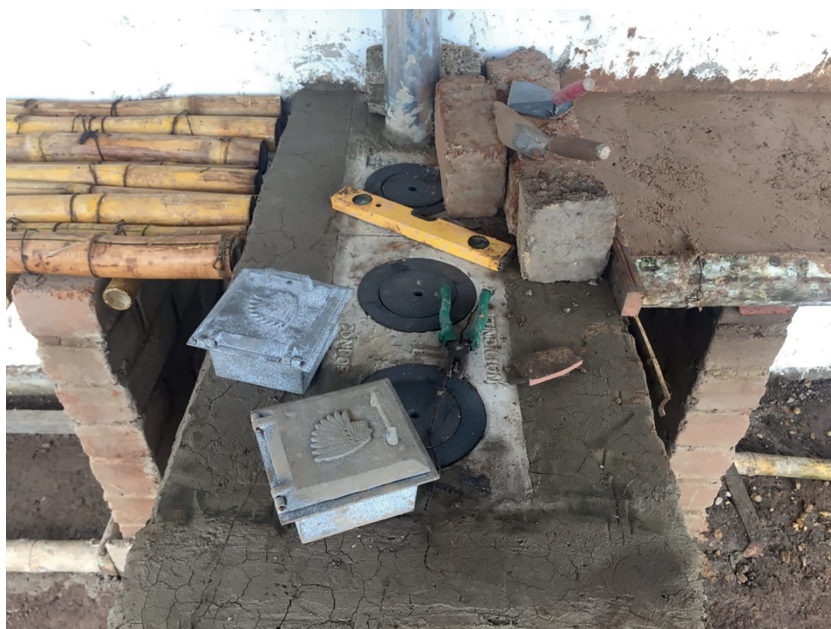
Figura 5. Estufa ecológica con tierra cruda en proceso de construcción
