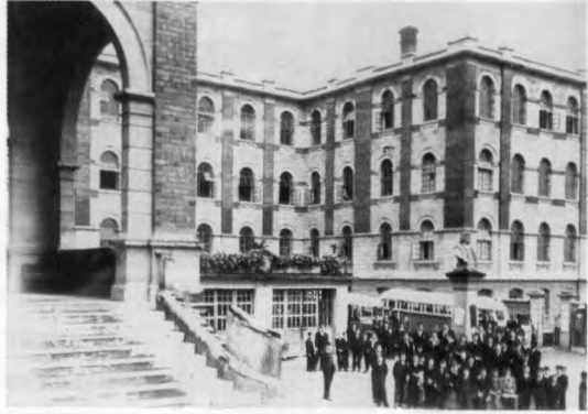
Foto: Vista construcción inicial, s.f.
