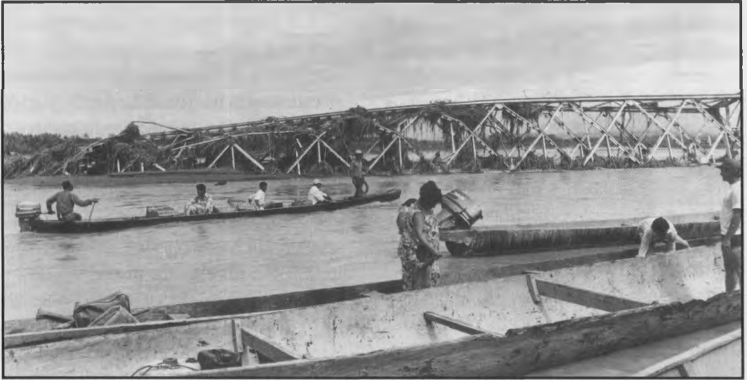
Puente "Guillermo León Valencia", Puerto Caldas (Meta), su caída dejó incomunicada a la mitad del país, y los efectos de su pésima construcción se vió reflejada en el encarecimiento del costo de vida de los colombianos.
