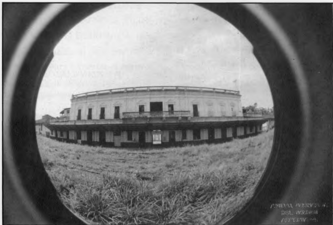
Estación de ferrocarril de Armenia (Quindío). Fachada Posterior
